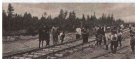
Строительство Транссибирской железной дороги. Отсыпка насыпи в районе с. Кривоцеёково, укладка рельсов
