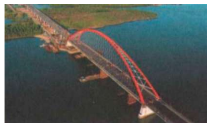
Бугринский мост через Обь (2014 г.)
