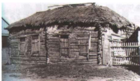
Жилой дом в с. Суздалка Доволенского района — памятник архитектуры середины XIX в.
