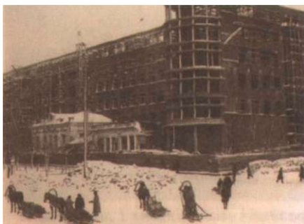
Строительство здания Крайисполкома (1931—1932 гг.)
