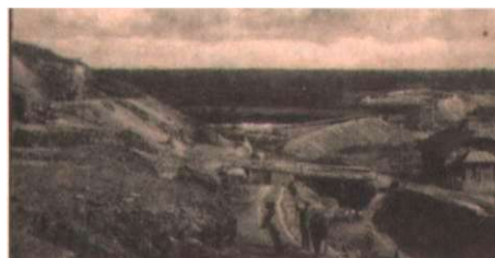
Выемка в районе мостового перехода через реку Иню
