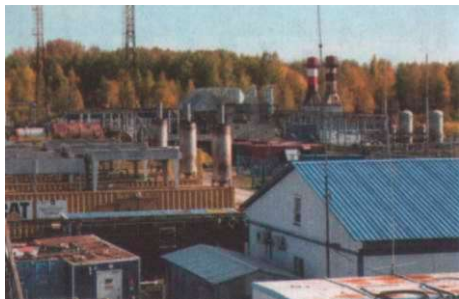
Энергокомплекс Усть-Таркского нефтяного месторождения (2014 г.)
