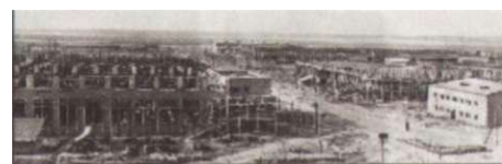
Строительство завода «Сибкомбайн» (1930-е гг.)
