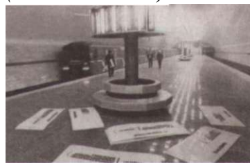
Станция метро «Зельцовская» готова к приему первых пассажиров. Последние приготовления перед торжественным открытием (март 1992 г.)
