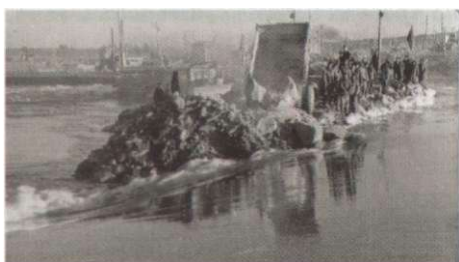
Перекрытие русла Оби при сооружении плотины Новосибирской ГЭС (1956 г.).
