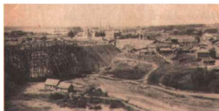
Вид строящегося моста через реку Каменку в Новониколаевске
