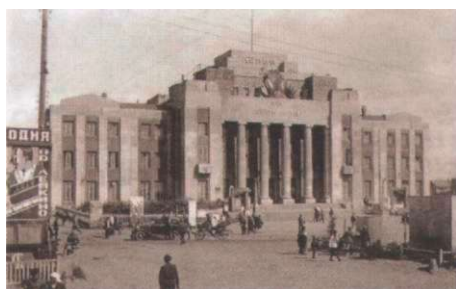
Дом Ленина после первой реконструкции (1926 г.)
