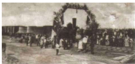
Прибытие первого поезда в Кузино (6 августа 1915 г.). Фото В. Янчевского
