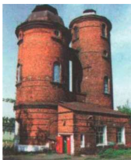
Насосная станция с двумя водонапорными башнями на железнодорожной станции Кутино, памятник архитектуры
